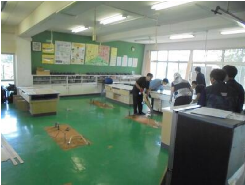
古いテーブルを撤去中。
